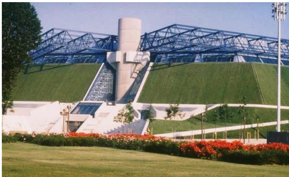
Рисунок 1.15 – Использование геомата для озеленения и водоотведения крыш [100]
