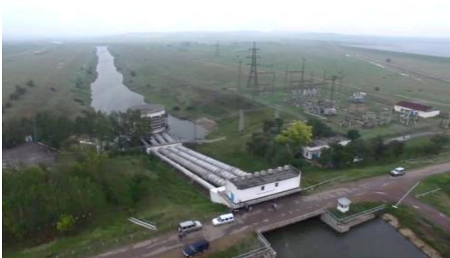
Рисунок 1.10 – Насосный гидроузел станции подкачки на открытом канале Иртыш- Караганда (общий вид)
