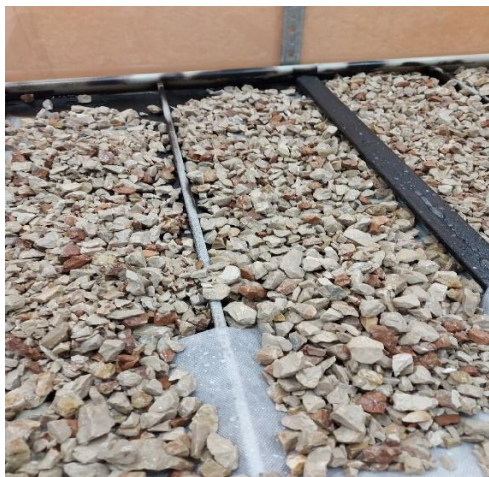
Рисунок 6 - Устройство дренажа вегетационной камеры
