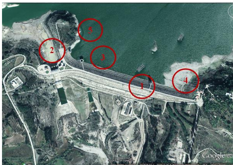
Рисунок 2 - Космический снимок сооружения гидроузла 16 Тишрин: 1 - грунтовая плотина; 2 - регулируемый береговой водосброс; 3 - нерегулируемый шахтно-башенный водосброс; 4 - левобережный ирригационный водовыпуск; 5 - ирригационный правобережный туннель
