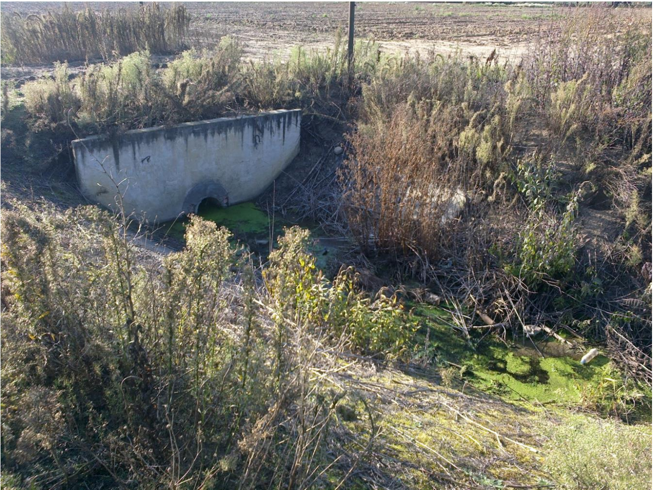
Рисунок 2.4 – Сооружение, растительность и наносы на осушительном канале
