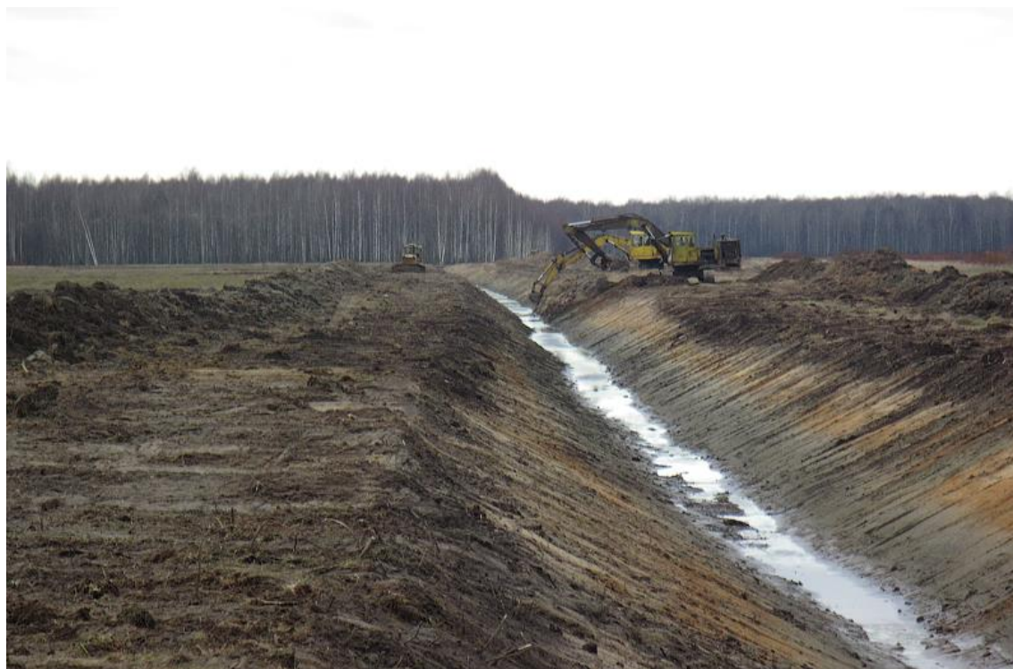
Рисунок 1.5 – Очистка канала с незакрепленным дном одноковшовыми экскаваторами
