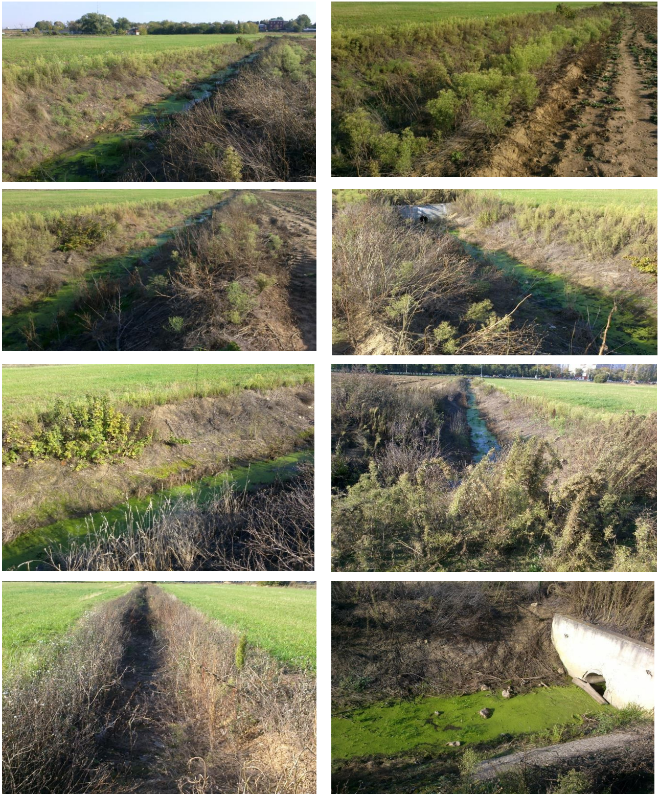
Рисунок 1.2 – Наличие в мелиоративных осушительных каналах наносов, заилений и растительности
