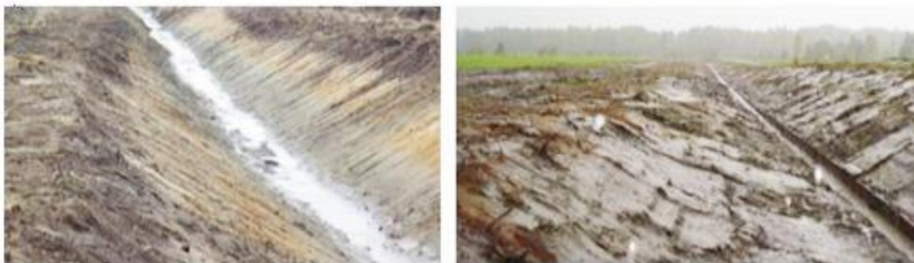
Рисунок 3.33 – Мелиоративный канал: а) без крепления дна; б) с закрепленным дном
